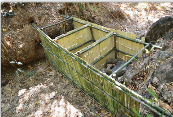
ที่มา: สำนักงานคณะกรรมการพิเศษเพื่อประสานงานโครงการอันเนื่องมาจากพระราชดำริ รูปที่ 17 : ฝายเพื่อชะลอน้ำและสร้างความชุ่มชื้นให้กับผืนป่า
