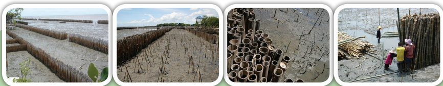
รูปที่ 16 : การสร้างแนวคลื่นขัดชายฝั่งเพื่อรับมือกับการเปลี่ยนแปลงสภาพภูมิอากาศ
